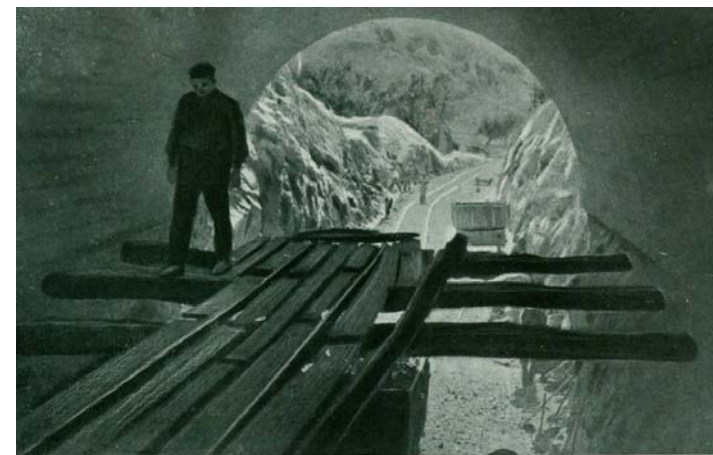
MAESTU. — Vista de la boca de entrada del túnel de la divisoria, tomada desde el interior de la galería ensanchada.
