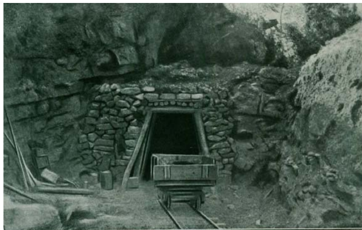
MAESTU. — Boca de entrada del túnel de la divisoria, comenzada solamente la galería de avance.
